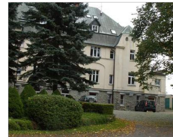
5. pohled na budovu správy NP od západu; kolem budovy žulová dlažba, prostor pro parkování; zeleň v okolí budovy je tvořena především vzrostlými jehličnany
