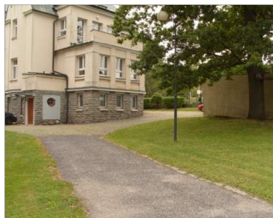
6. pohled na budovu a garáže (vpravo) od jihozápadu
