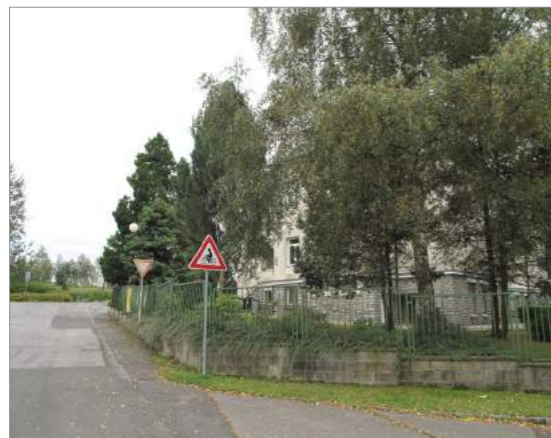
1. pohled na oplocení a zeleň před budovou, severovýchodní roh
