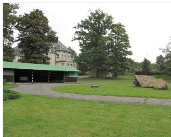
20. pohled na parkovací přístřešek, přístupný z centrální plochy areálu /nikoliv od vjezdu; v popředí kameny, tvořící základ připravované geologické expozice
