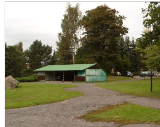
47. plechový přístřešek pro parkování vozidel Správy NP; vjezd je orientován nelogicky z jihu, nikoliv od budovy a příjezdu na pozemek
