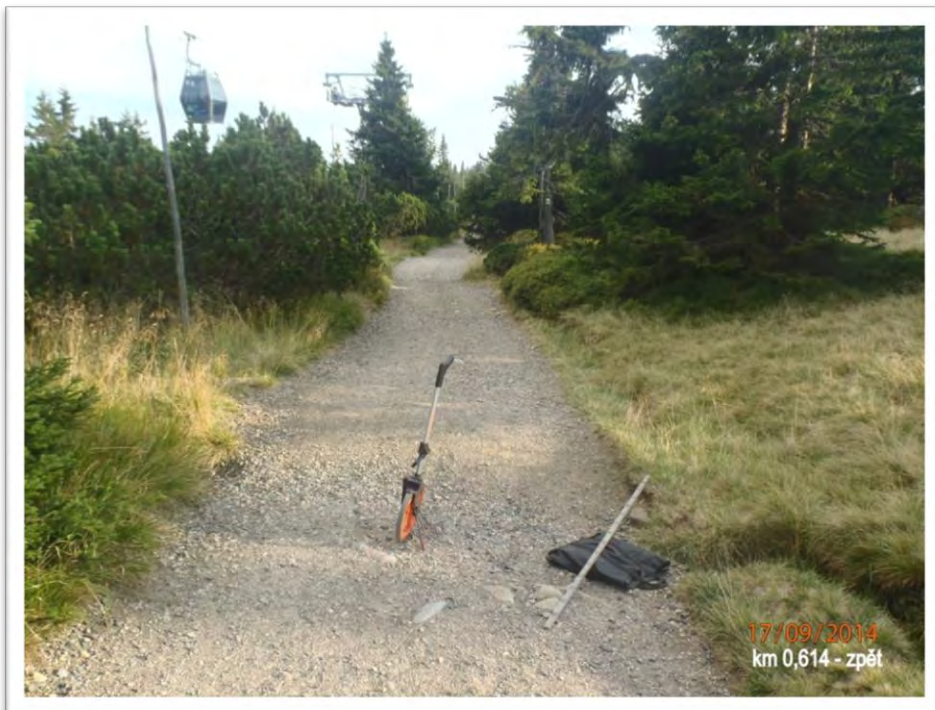
Obr.1.: Příčný odvodňovací rigol v km 0,614
