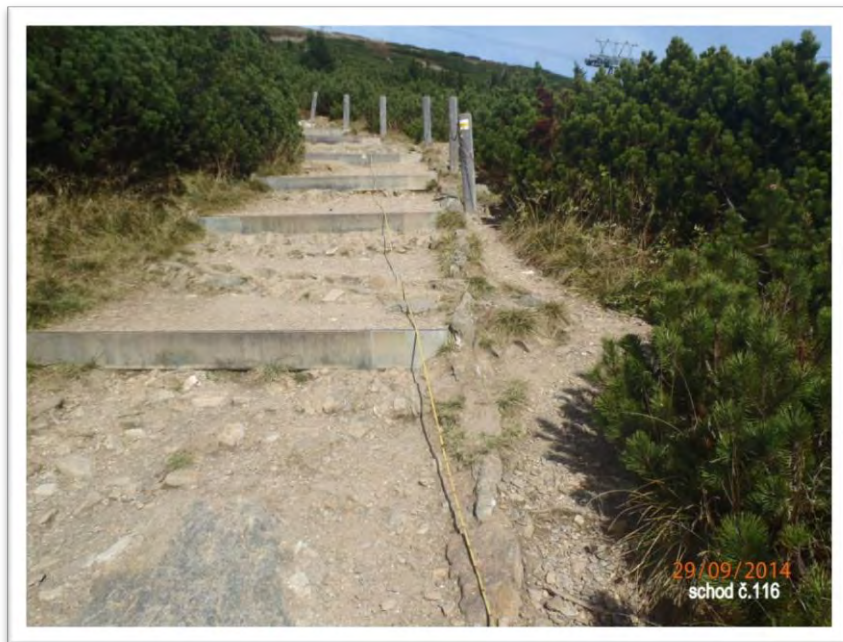
Obr.1.: Původní dřevěné sloupky - k odstranění
