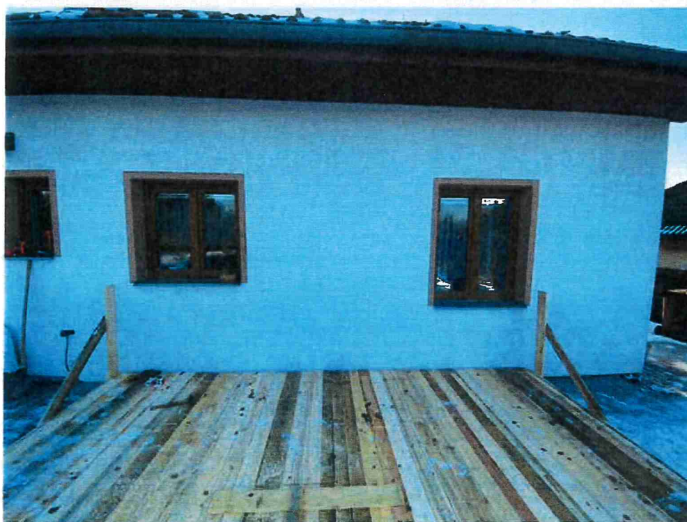
Stav RD během havarijního zásahu
