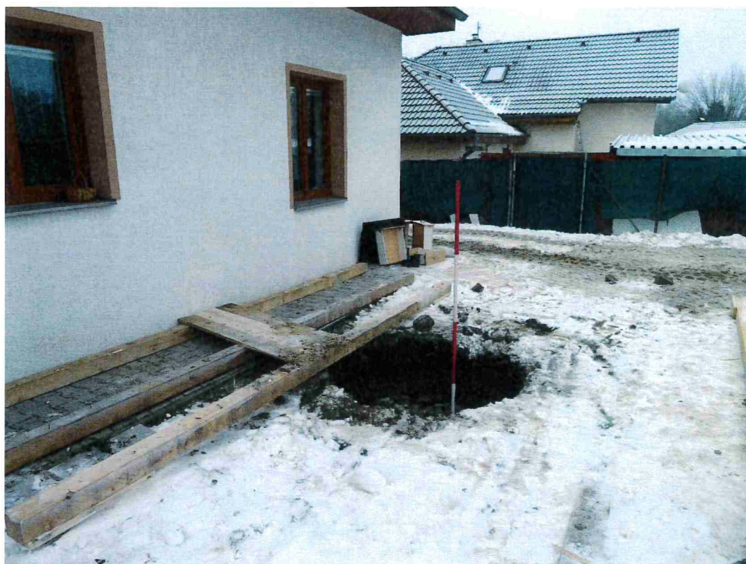
Foto č. 3: Celkový pohled na zasypávání propadu (foto: 21. 1. 2026, RNDr. Pavel Šír)
