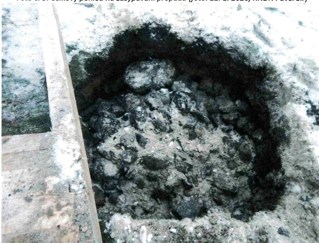
Foto č. 4: Detailní pohled do zasypávaného propadu (foto: 21.1.2026, Mgr. J. Skřivánková)
