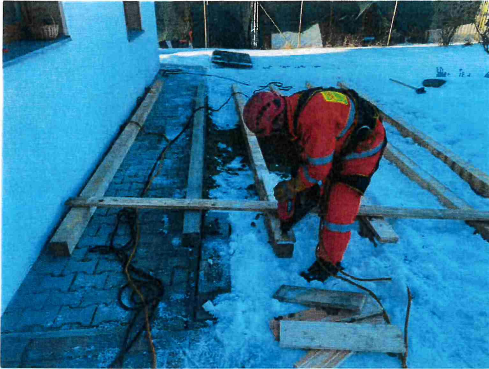
Budování nosné konstrukce povalu
