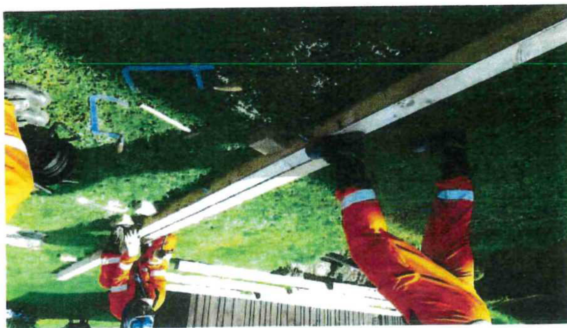
Výroba nosných prvků povalu
