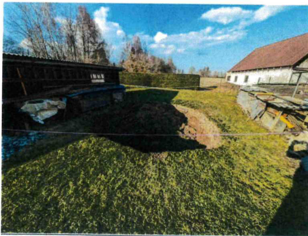
Obr. 4: Propad, pohled od JZ.
