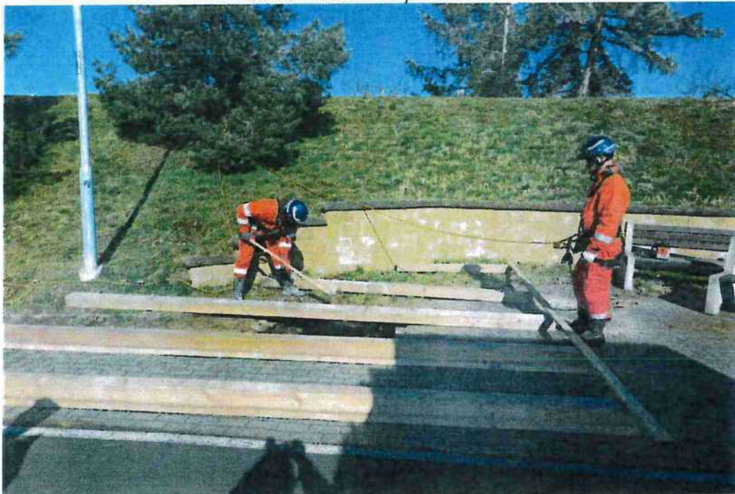
Stavba ochranného povahu
