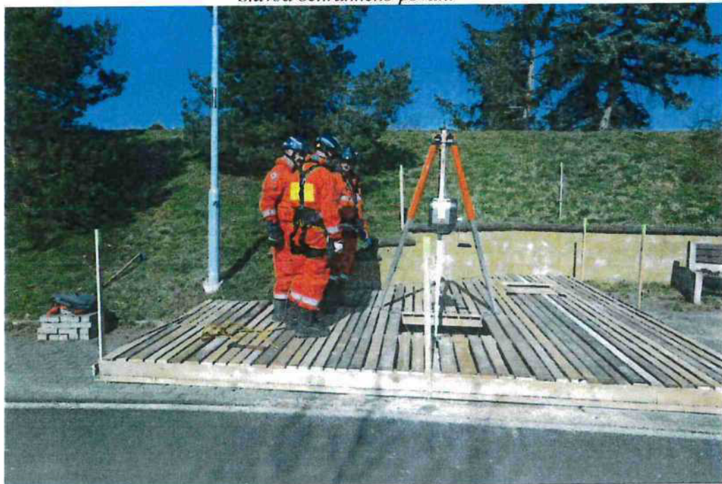
Stavba ochranného povahu
