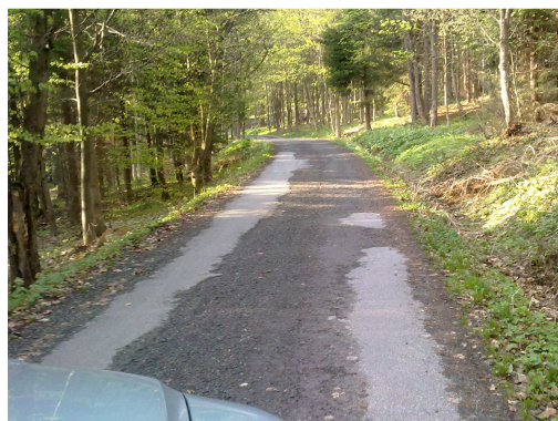
Obr. 2 Komunikace z penetračního makadamu
