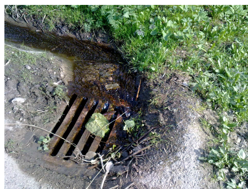
Obr. 4 Staničení km 0,008 00; potřeba zvednutí vpusti
