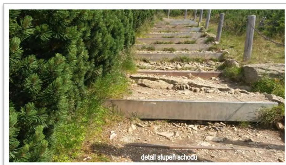
Obr.3.: Snižovaný terén pod stupněm schodu č. 164
