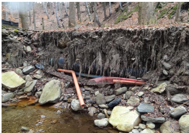
Obr. 51 Úsek 13 – obnažená korugovaná DN 500 na levém břehu
