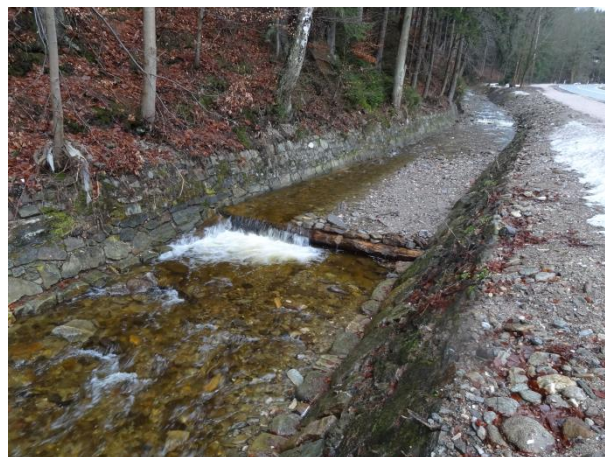
Obr. 17 Úsek 4 – Strmý svah na PB a jeho zpevnění strmou dlažbou. Ve dně dřevěný zachovalý pás
