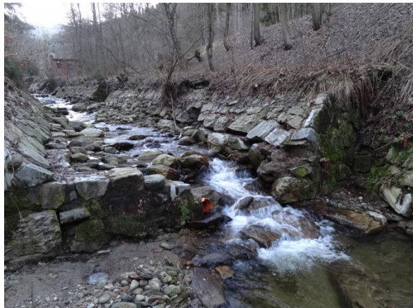
Obr. 29 Úsek 7 – poškozené opevnění a zničené stupně
