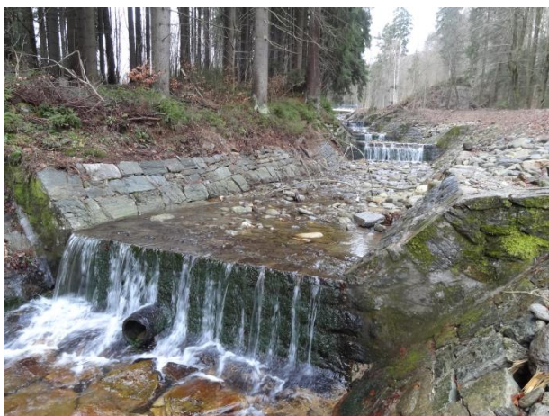
Obr. 40 Úsek 10 – zachovalá nebo mírně poškozená kaskáda stupňů a opevnění
