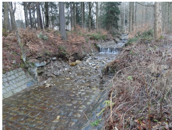
Obr. 46 Úsek 12 Poškozené opevnění a stupeň, zachovalé hladké dopadiště (pohled proti proudu)
