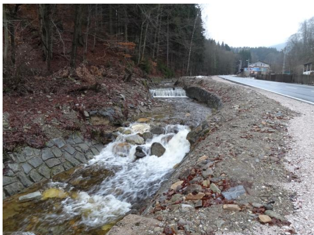
Obr. 16 Úsek 4 – zničený stupeň v popředí, zachovaný stupeň v pozadí. Na LB navážka po povodních.
