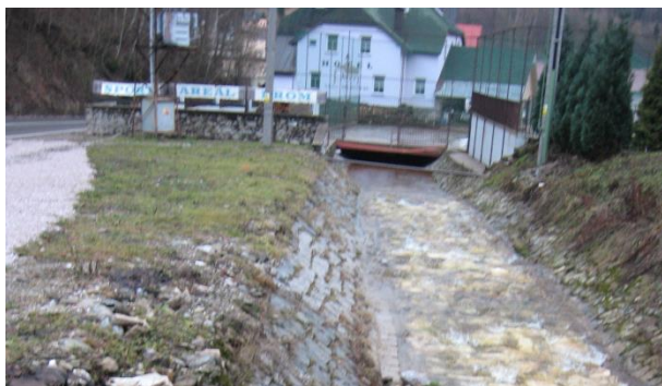
Obr. 12 Úsek 3 - zastropení toku (hřiště) a okolní zdi. Koryto opevněno dlažbou
