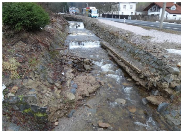
Obr. 15 Úsek 4 – poškození nad mostem ř. km 0.5381
