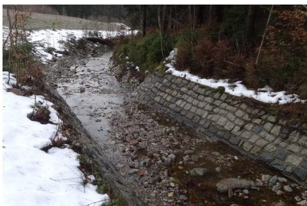
Obr. 36 Úsek 9 - zchovalá dlažba stylu řádkové zdivo. Kámen (kopáky) různých materiálů
