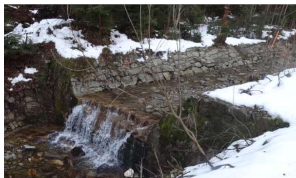
Obr. 35 Úsek 9 - poškozený stupeň – oprava typu 2
