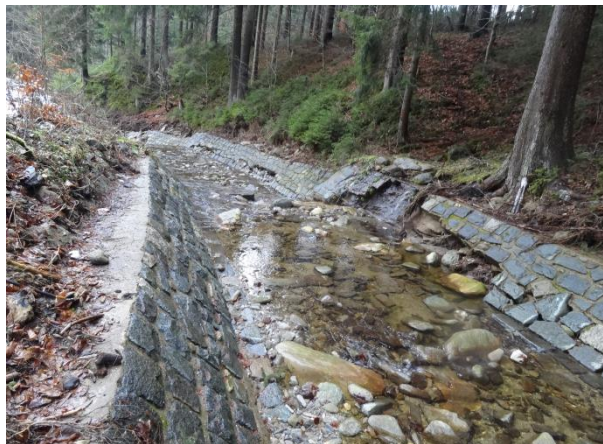
Obr. 39 Úsek 10 – bodově silně poškozená dlažba
