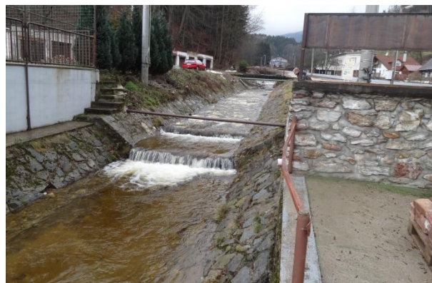
Obr. 13 Úsek 3 –kamenný stupeň ve dně a nad ním dřevěný práh (pohled proti proudu)
