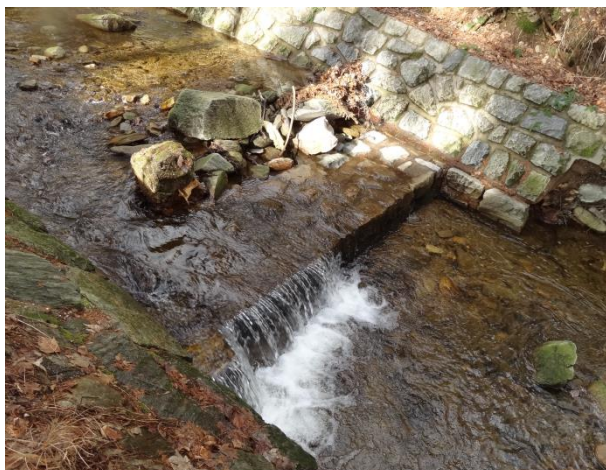
Obr. 56 Úsek 14 - stabilizační práh ve dně a zachovalé opevnění
