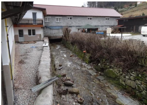
Obr. 8 úsek 2 – zatrubnění. Nevhodné z hlediska odtokových poměrů.
