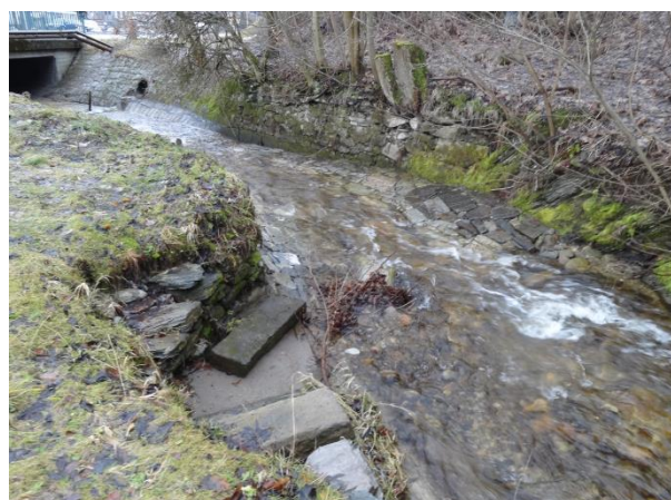
Obr. 7 Břehová nátrž a poškozený přístup k toku na LB
