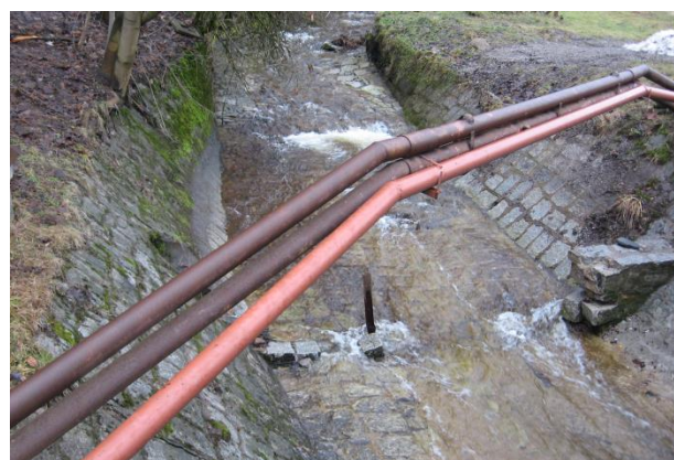
Obr. 6 Poškozený nízký stupeň nad mostem ev. č. 296-003 (pohled proti proudu)
