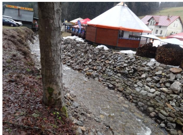
Obr. 25 Úsek 6 – opevnění PB. Torza původního opevnění z MK
