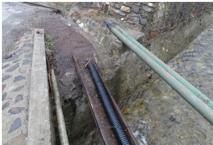
Obr. 9 Křížení sítí – chráničky – most ř. km 0,417
