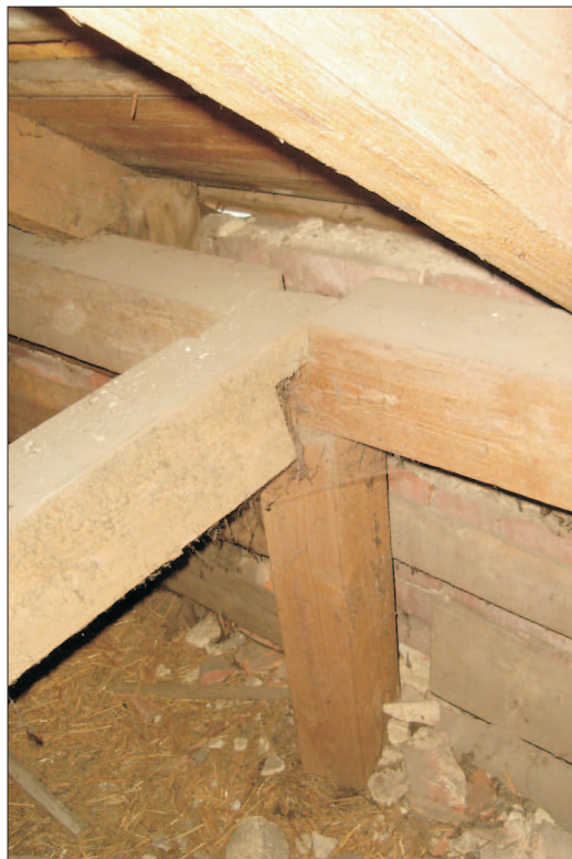
krov - porušení spojů
