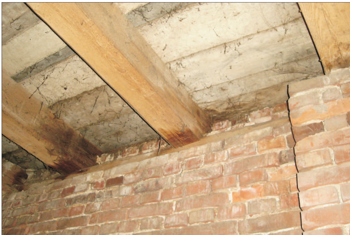
objekt stodoly - dřevěná stropní konstrukce - vlhkost v místě uložení trámů
