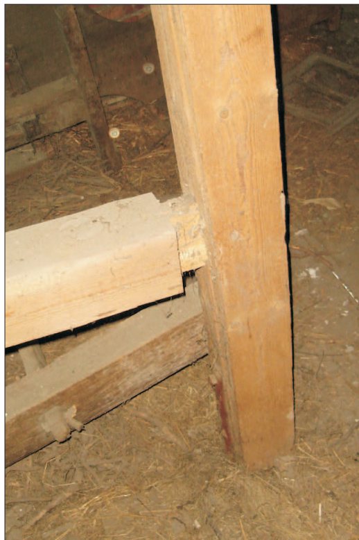
krov - porušení spojů
