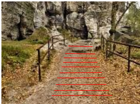
Obr.10 – Schody u č. 11 – HERKULOVY SLOUPY
