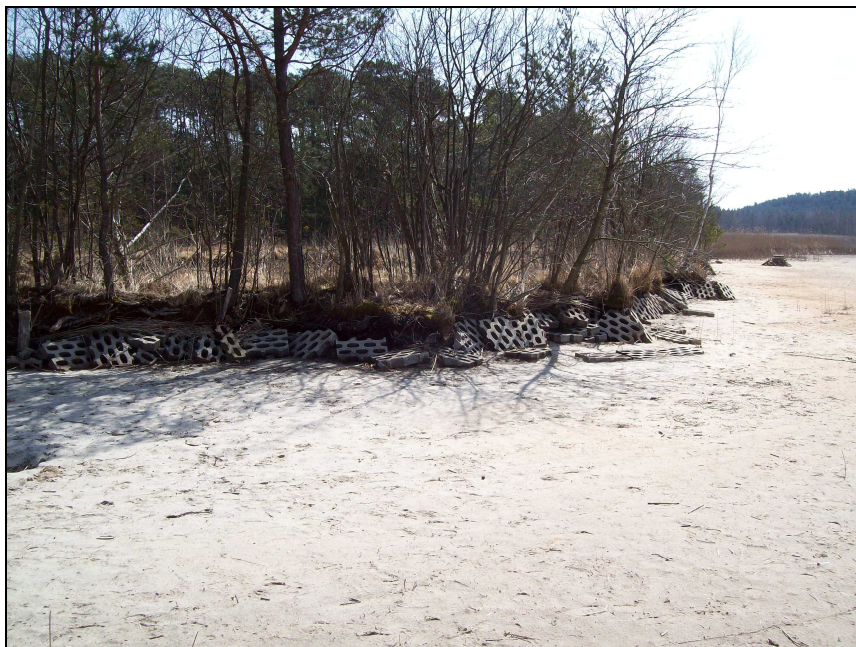
Pohled na hrázku s poškozeným opevněním
