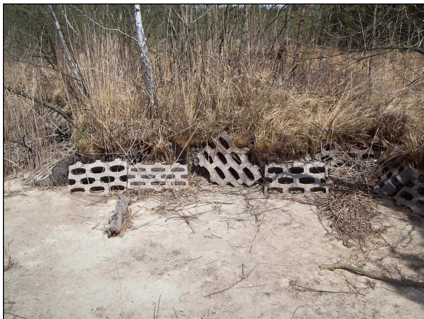
Detailní pohled na poškozené opevnění hrázky
