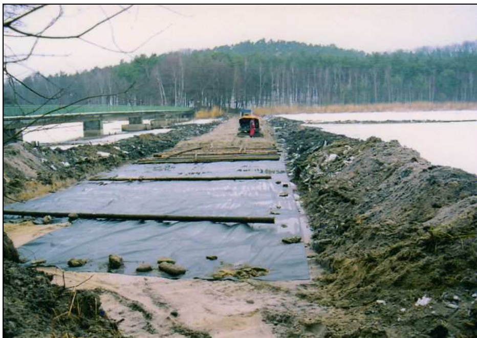
Dřevěný rošt v základové spáře hrázky (Ing.Hýzler)
