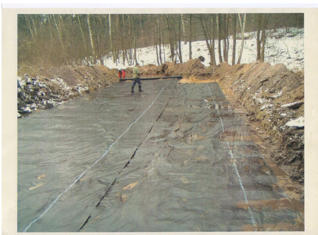
Folie v základové spáře hrázky (Ing.Hýzler)
